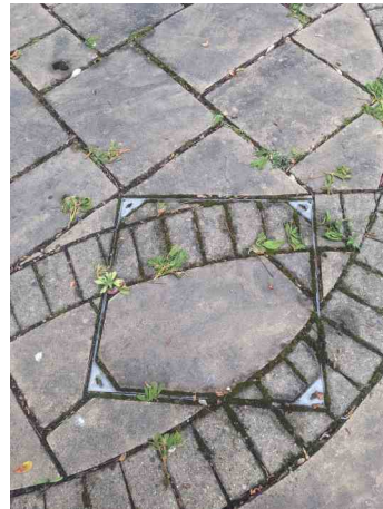
MH.18 PRE SURVEY
