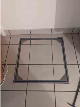
MH.3 PRE SURVEY
