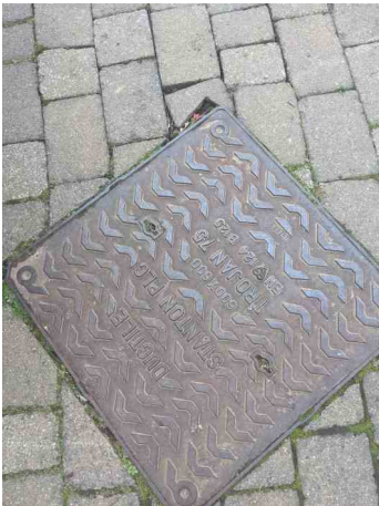
MH.20 PRE SURVEY
