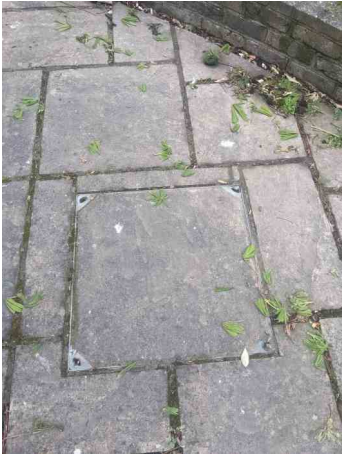
MH.16 PRE SURVEY
