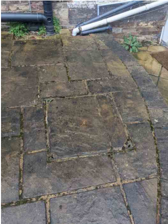
MH.10 POST SURVEY
