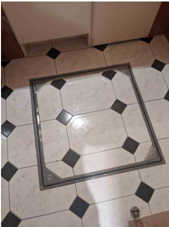
MH.1 PRE SURVEY
