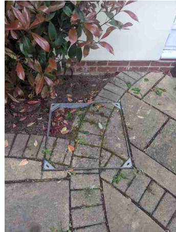
MH.7 PRE SURVEY
