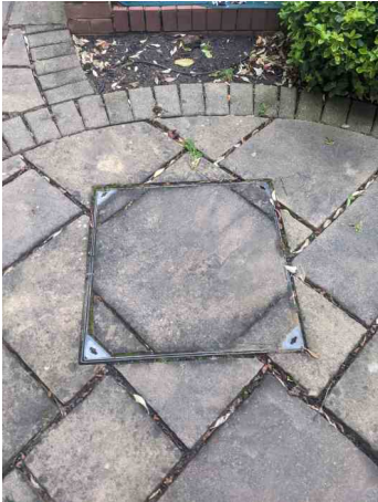
MH.19 PRE SURVEY
