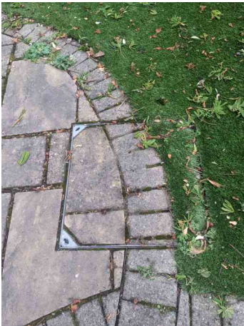
MH.17 PRE SURVEY
