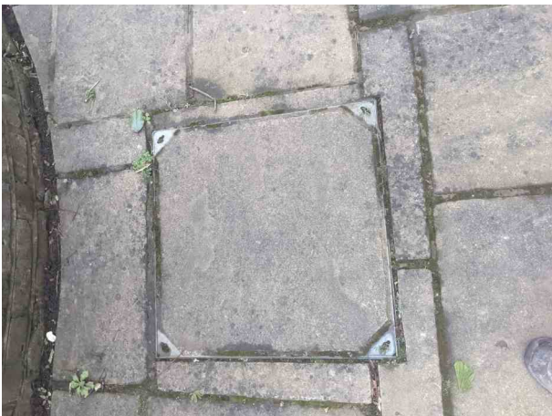
MH.15 PRE SURVEY
