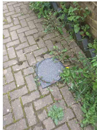
MH.26 PRE SURVEY
