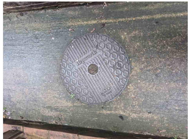
MH.12 PRE SURVEY
