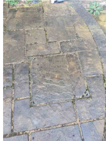
MH.10 PRE SURVEY
