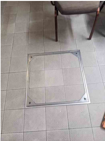
MH.4 PRE SURVEY
