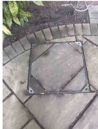
MH.9 PRE SURVEY
