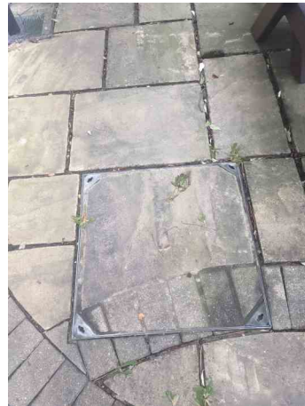
MH.8 PRE SURVEY
