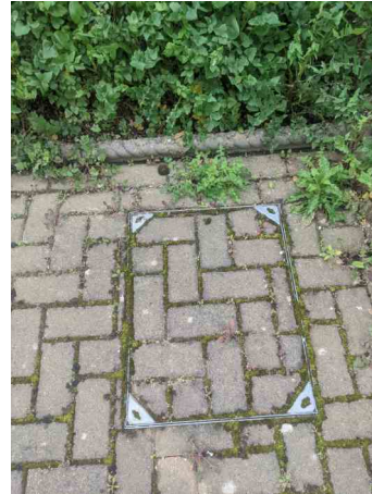
MH.27 PRE SURVEY
