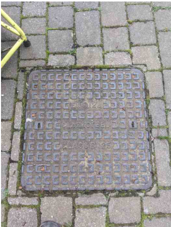
MH.21 PRE SURVEY
