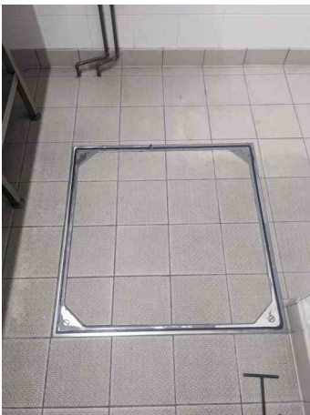
MH.5 PRE SURVEY
