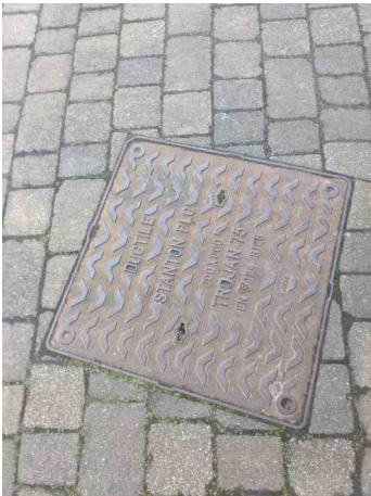
MH.24 PRE SURVEY
