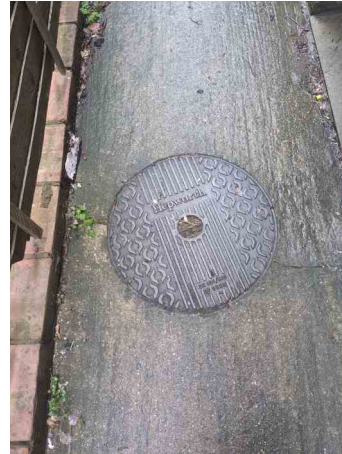
MH.13 PRE SURVEY
