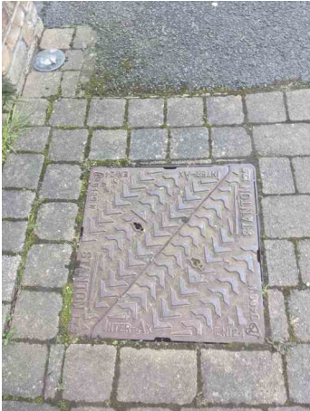
MH.23 PRE SURVEY
