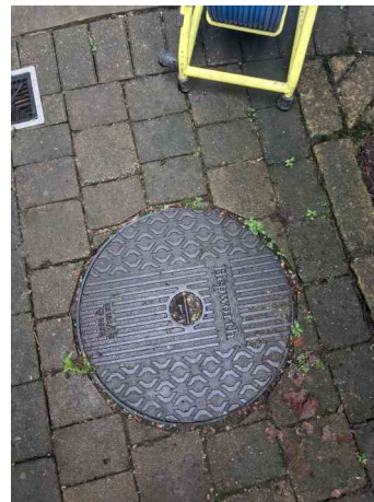
MH.11 PRE SURVEY
