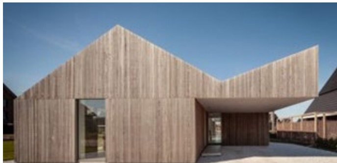
Francois Verhoeven Architects
