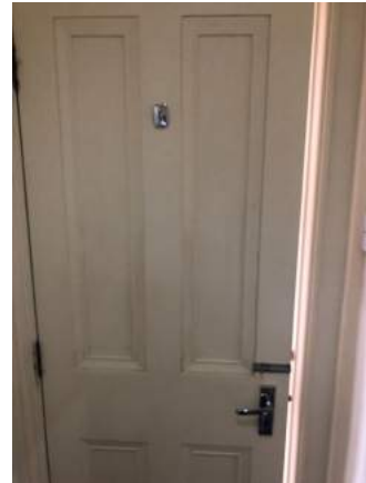
Existing WC door
