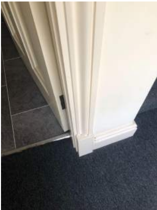
Existing door architrave
