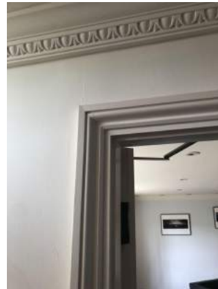
Existing door architraves
