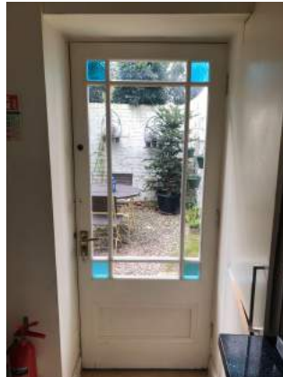
Existing external door
