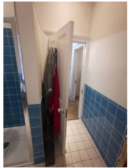
Existing door D-023-02
