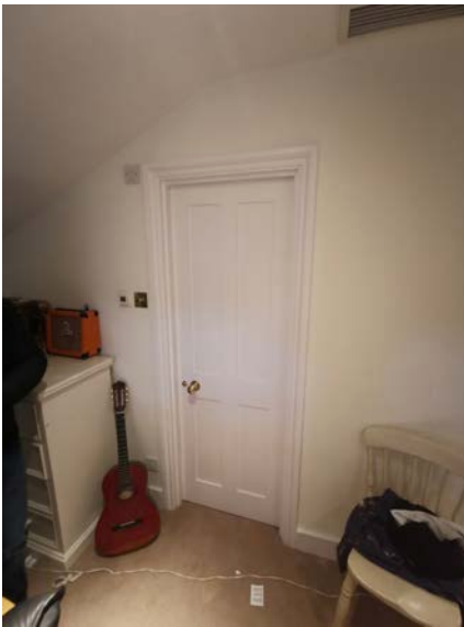
Existing door D-024-02
