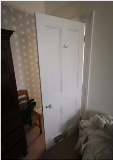
Existing door D-023-03
