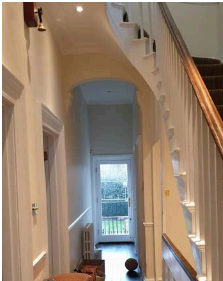
Existing modern door D-022-06
